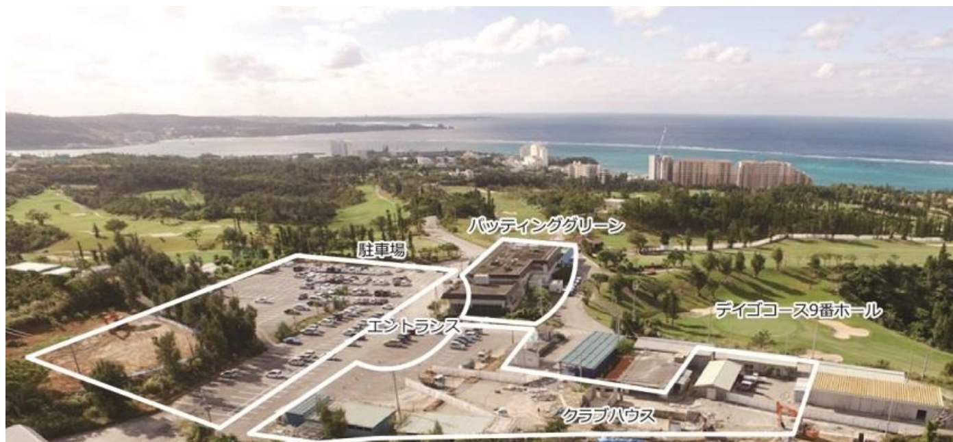
現在の様子と完成後の配置(2015年12月下旬撮影)
